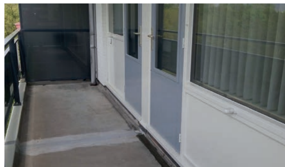
Het eindresultaat: de gevelpanelen zijn geplakt, de kozijnen geschilderd en de randen afgekit
